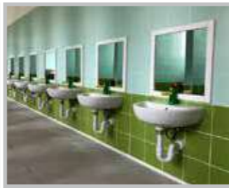
Scuola dell'infanzia Kindergarten MESENZANA - ITALY
