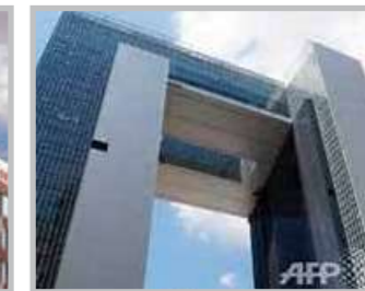
Palazzo delle autorità governative Government building of port authorities - HONG KONG
